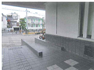
入口 スロープ
