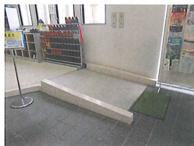
玄関 スロープ
