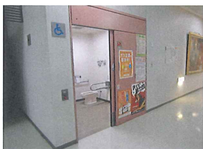
開閉ボタン付きの自動ドアで 内部に手すりのある多目的トイレ
