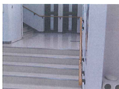
階段には手すりを設置
