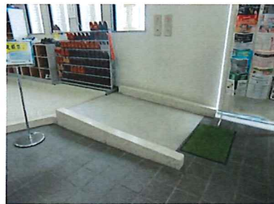
玄関 スロープ
