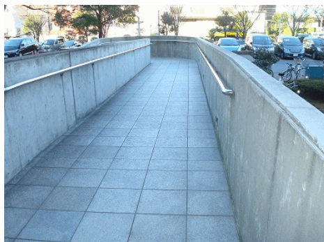
体育館棟入口へのスロープ 手すりも設置されています
