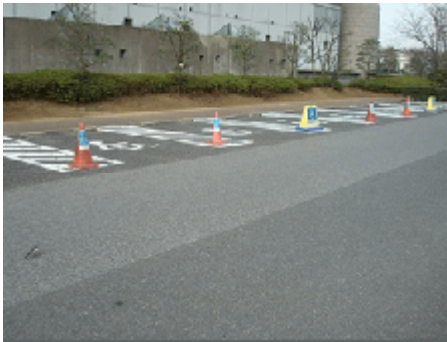
車椅子にも対応している障がい者駐車場
