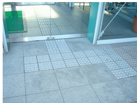
入口からの点字ブロックもあります
